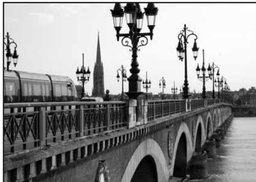
Le pont sur la Garonne, le cheminement de deux cultures proches.
